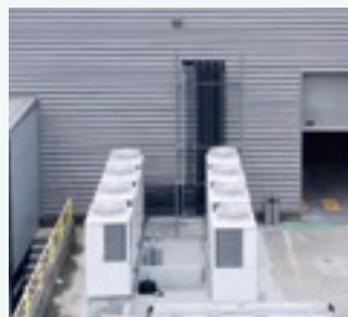
STEMCELL Technologies, globalna biotehnoška kompanija, instalirala je CO 2 jedinice za kondenzovanje za hladnjače u skladištima. Francuska. Rashladivanje
