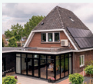
Aquarea T-CAP pruža kompletno rešenje grejanja, hlađenja i DHW za restauraciju luksuzne kuće u Voorthuizen, Holandija. Aquarea
